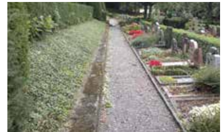
Schotter-, Kies- und Splittwege
